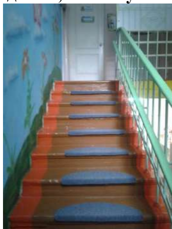
Фото№61 Второй лестничный марш для входа в группу
