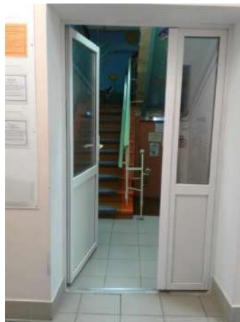
Фото №28 Вход в административную часть здания
