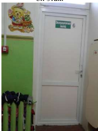
Фото№63 Наружная лестница – эвакуационный выход из группы
