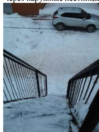
Фото№53 Наружная лестница – эвакуационный выход из группы
