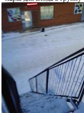
Фото№64 Наружная лестница – эвакуационный выход из группы
