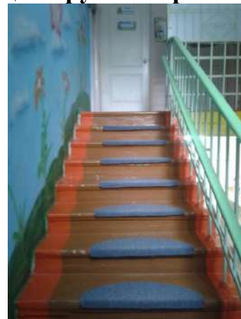
Фото№47 Второй лестничный марш для входа в группу
