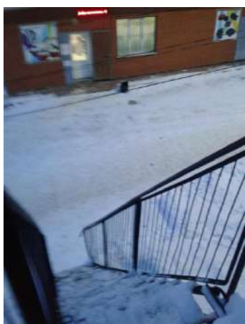
Фото№51 Наружная лестница – эвакуационный выход из группы
