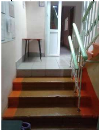
Фото№45 Вход в группу на 2-ой этаж
