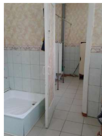
Фото№68 Вход из умывальной в туалет
