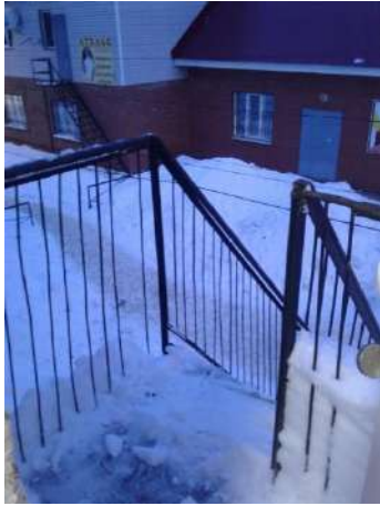
Фото№54 Наружная лестница – эвакуационный выход из группы
