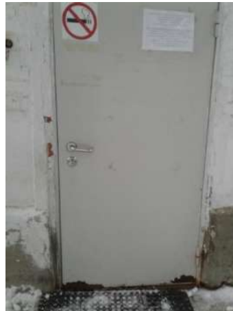
Фото№19 Основная входная дверь в здание
